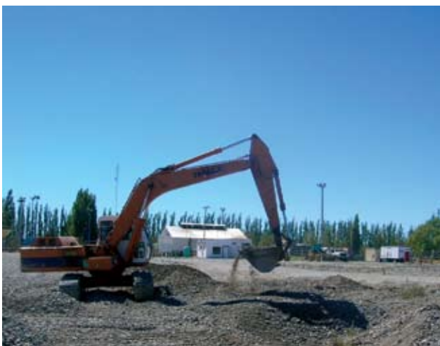
Figura 4. Remoción de la capa superficial de suelo
