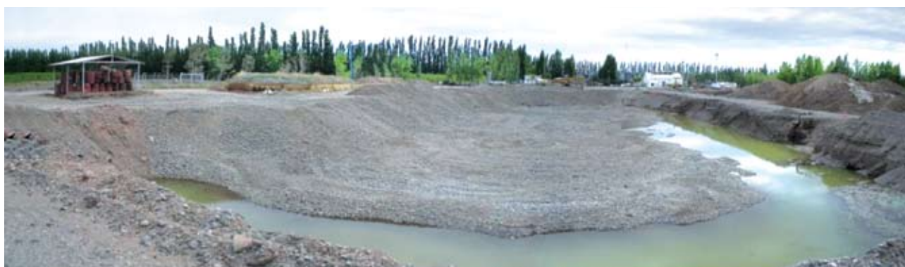
Figura 9. Relleno de áreas ya saneadas
